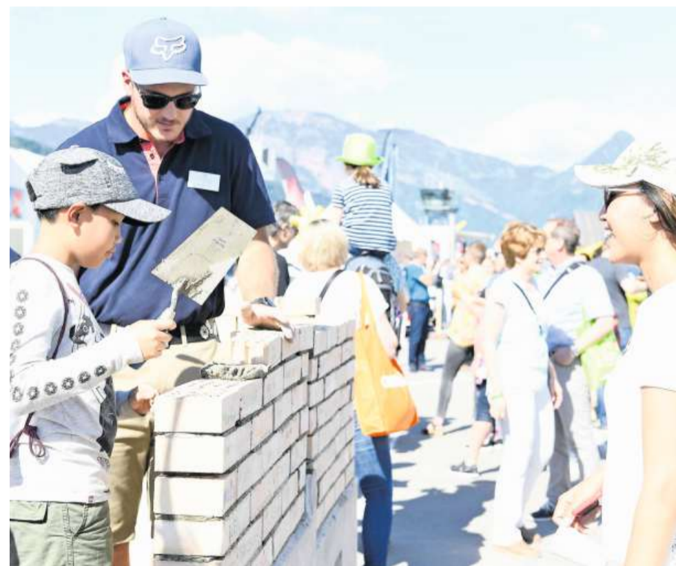
Fleiss für ein temporäres Mauerwerk.
